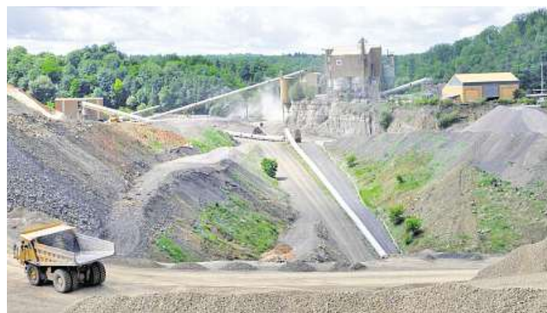
Seit Monaten ein Streitpunkt: der Steinbruch in Enzberg.
