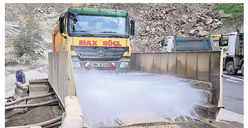
Mithilfe einer speziellen Waschstraße werden die Reifen der Lastwagen gereinigt.
